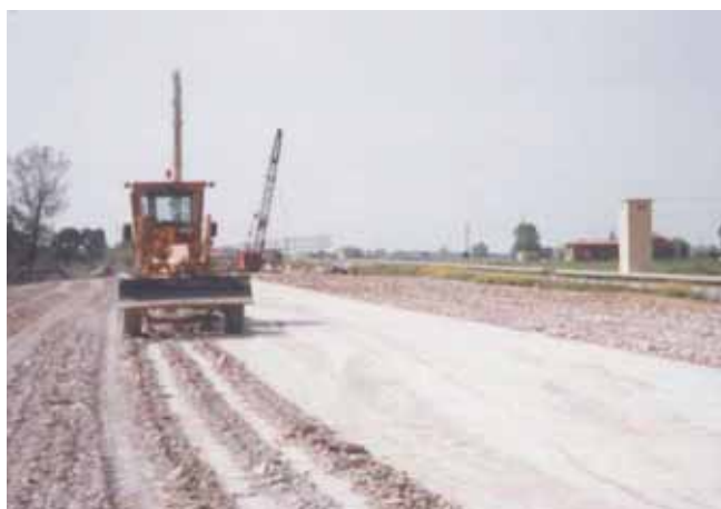
Fig. 4 Epicatura preliminare alla stesa dello strato successivo
