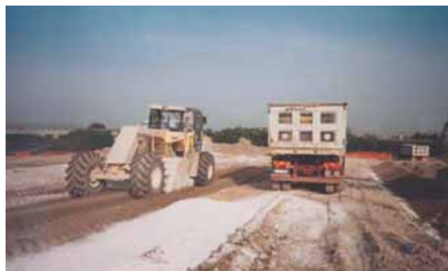
Fig. 2 Miscelazione della terra con la calce
