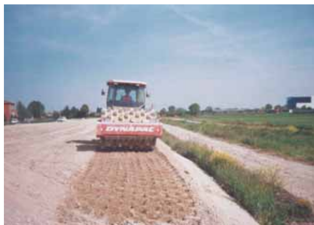
Fig. 3 Rullatura con rullo a piede di montone
