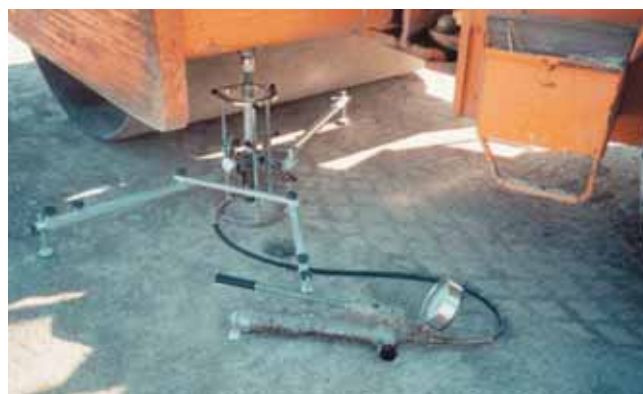
Fig. 5 Prova di carico su piastra
