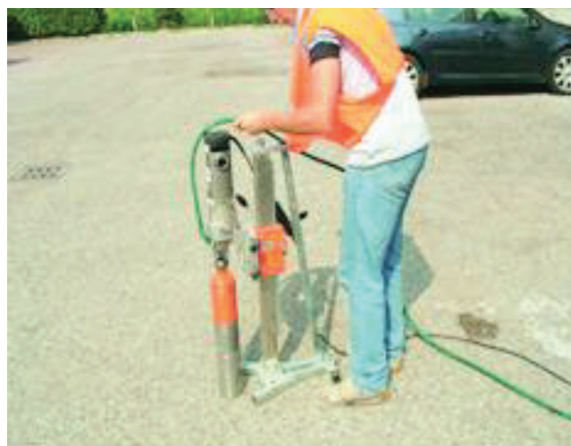
Fig. 6 Prelievo di campioni mediante carotaggio meccanico
